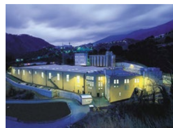
Stabilimento di Arenzano (GE)
